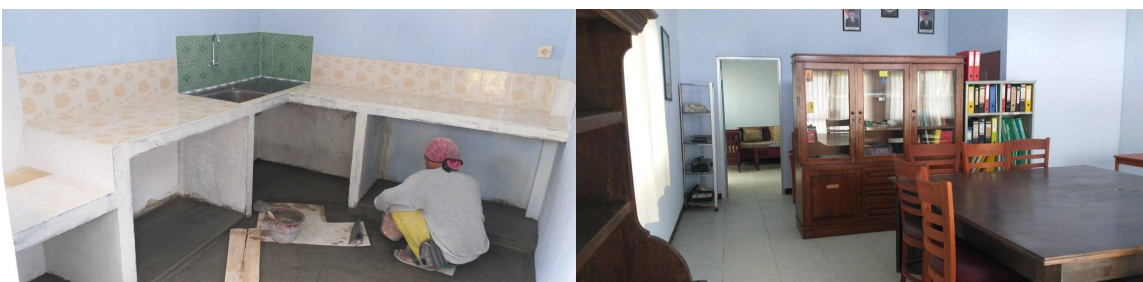
In de overige ruimtes wordt de verbouwing ook afgerond
