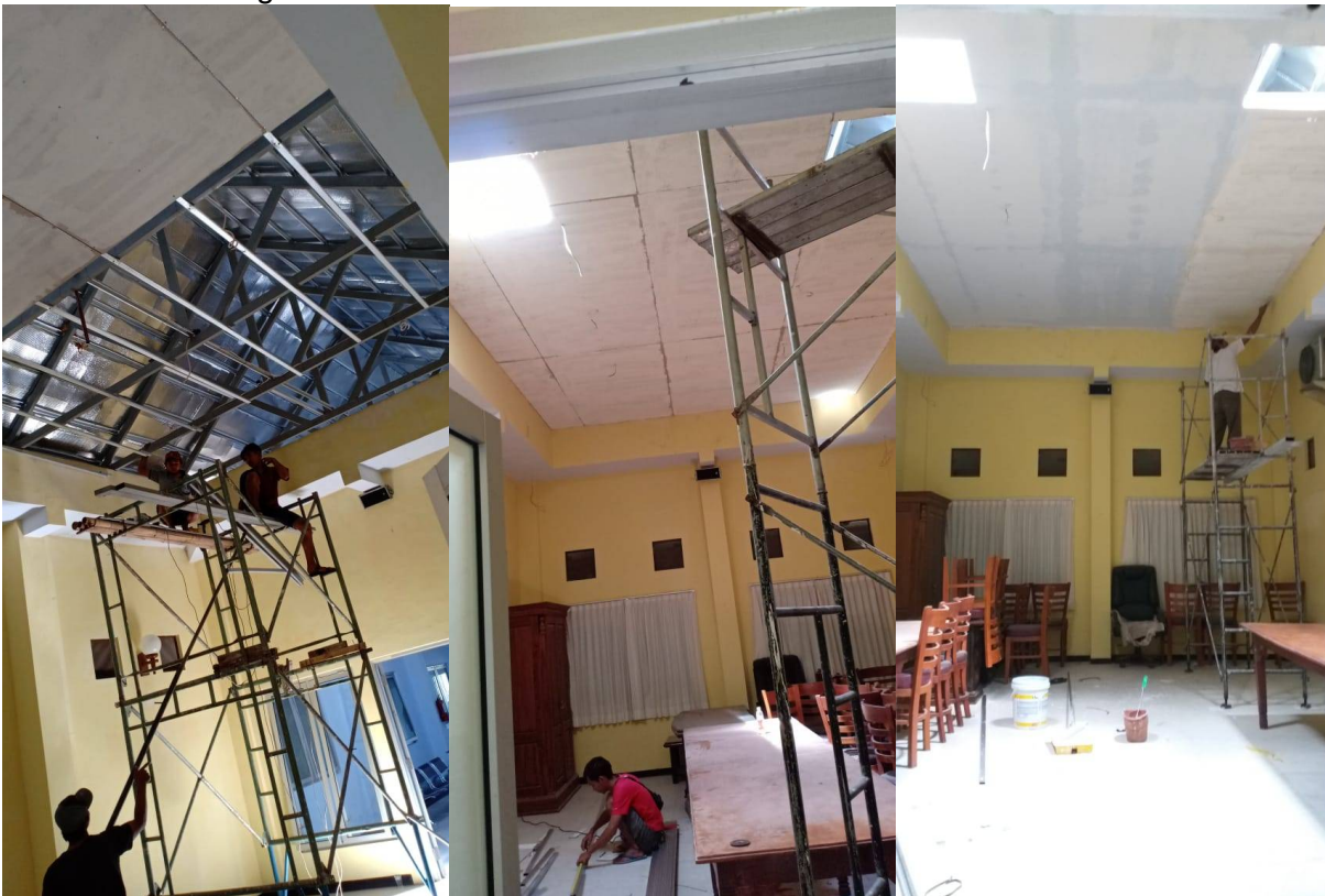
Het dak is vernieuwd
