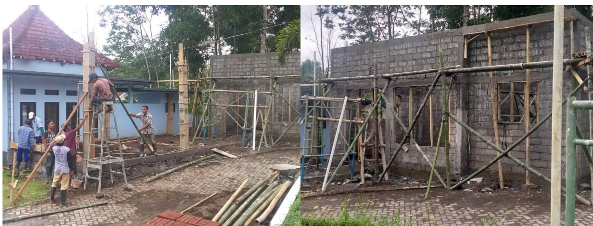
Bouw van de kantine
