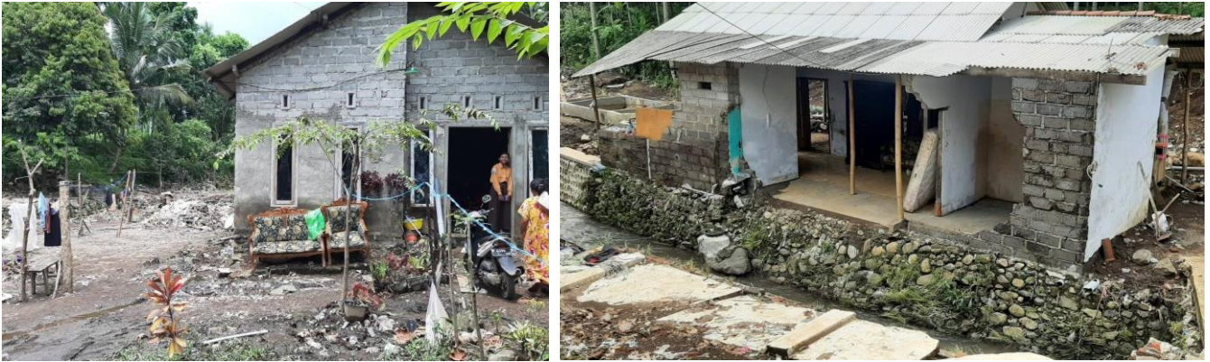
Enkele van de onbewoonbare huizen
